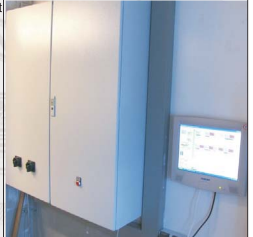
Bild 8: SPS-Schrank mit Touchbedienmonitor
