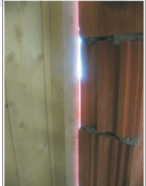
Bild 4: undichte Stalltüren
