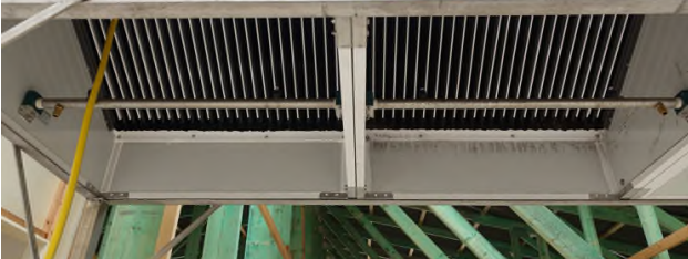
Blick in einen der beiden Wärmetauscher
