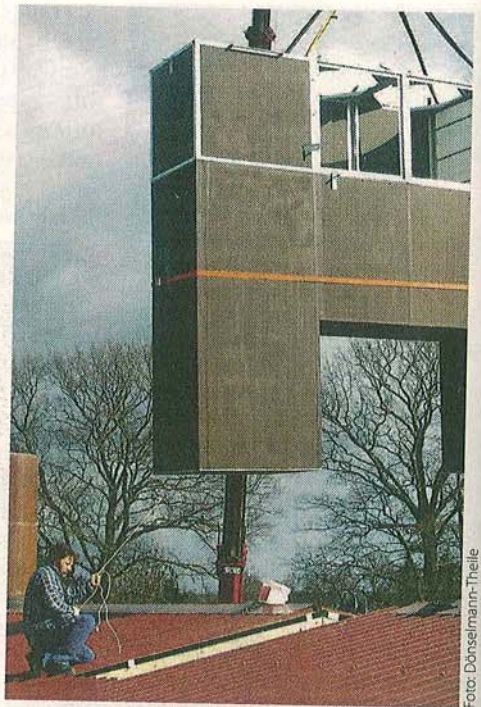
Der Wärmetauscher wird bei der Montage von oben in den Dachraum des Stalls eingesetzt.
