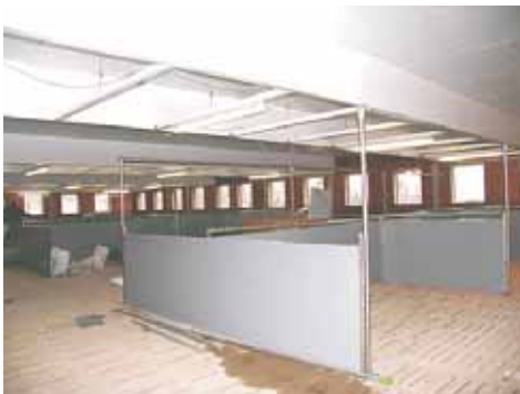
Bild 3: Zuluftmontage im Wartestall
