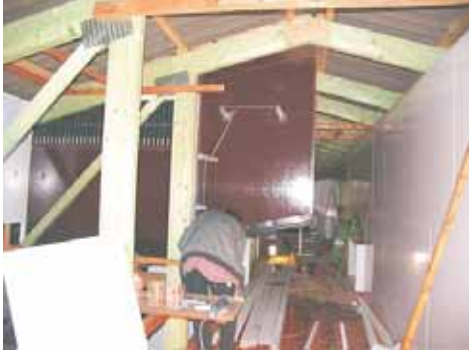
Bild 3: Zuluftmontage im Wartestall
