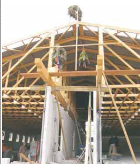
Bild 10: Richtfest des Stalles
