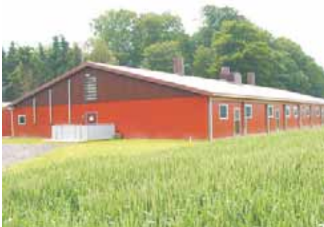
Bild 3: Ein ordnungsgemäß verarbeiteter Leichtbaustall
