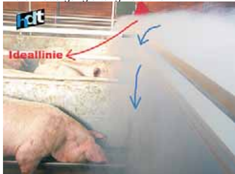
Bild 6: Futterganglüftung Zuluft kalt
