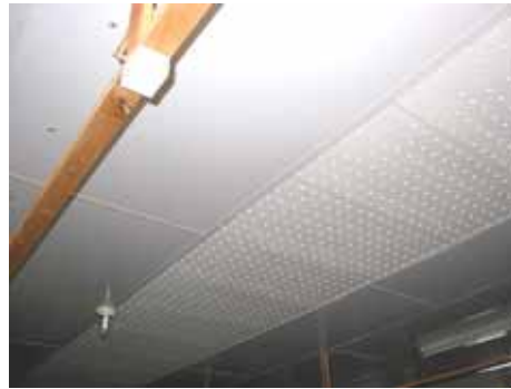
Bild 3: ungelochte Platten fest verschraubt, Lochplatten herausnehmbar in einem Abferkelstall
