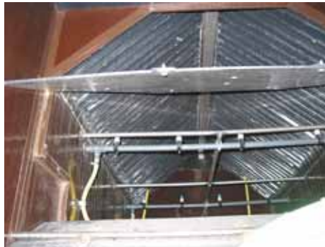
Bild 13: Tauscher 1/2 Jahr im Betrieb mit modifizierter Wäsche nach Betrieb der Wäsche
