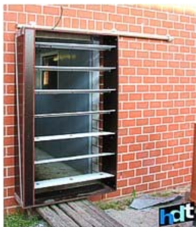
Zuluftrahmen als Schiebetür
