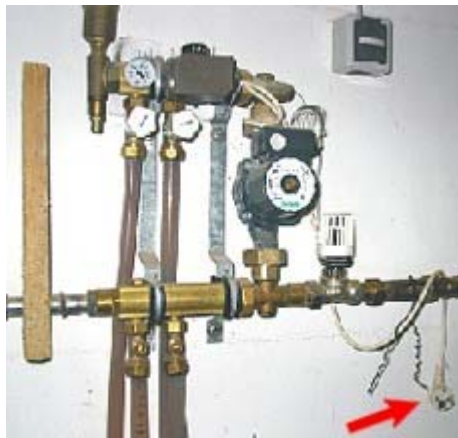
Bild 4: Regelung manuell für die Abferkelabteile
