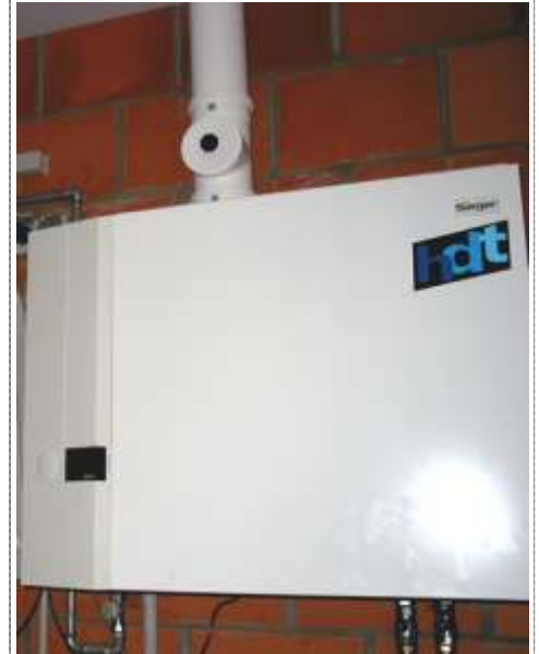
Bild 2: Ein Brennwertkessel
