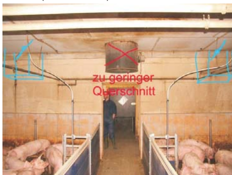
Bild 2: Die Änderung in einem Abteil vor dem Umbau (blau markiert)
