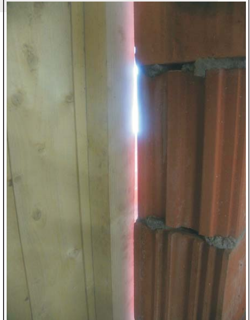
Bild 4: undichte Stalltüren
