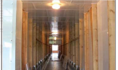
Bild: Der zentrale Zuluftkanal
