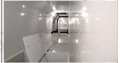
Bild: Der zentrale Zuluftkanal
